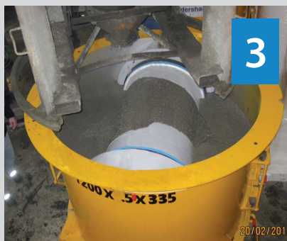
Stålform fylles med selvkomprimerende betong
