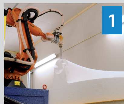
Fresing av EPS-blokk til renneløpsform
